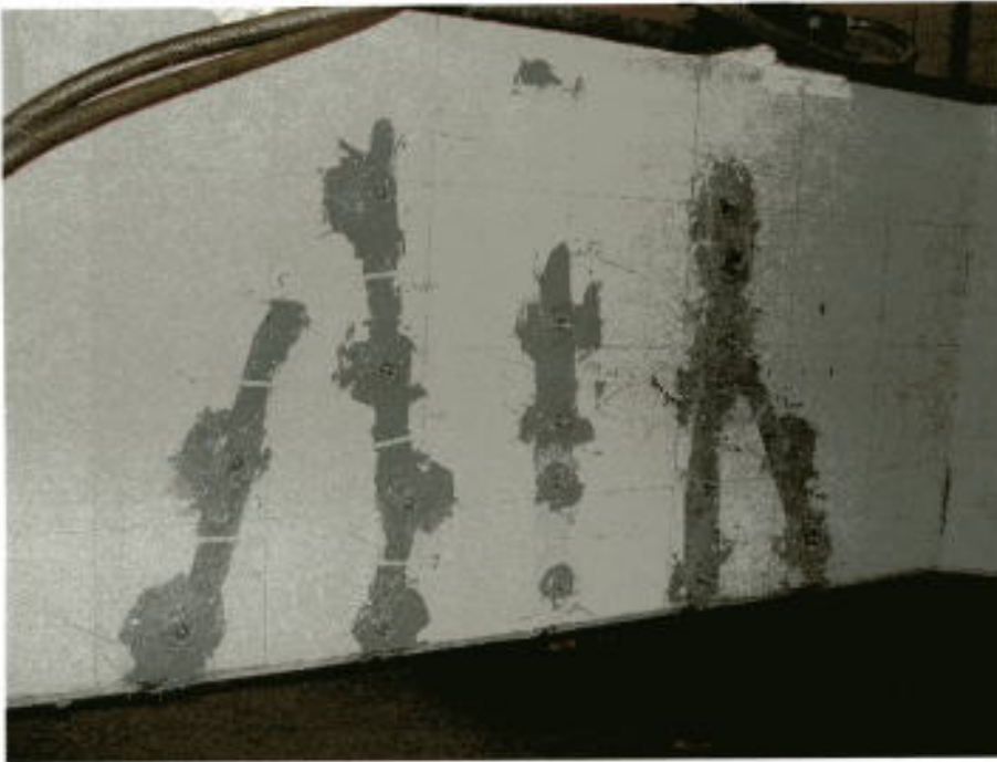
Bild 10: Balken 1 – verdämmte Risse, Anordnung der Einfüllstutzen
