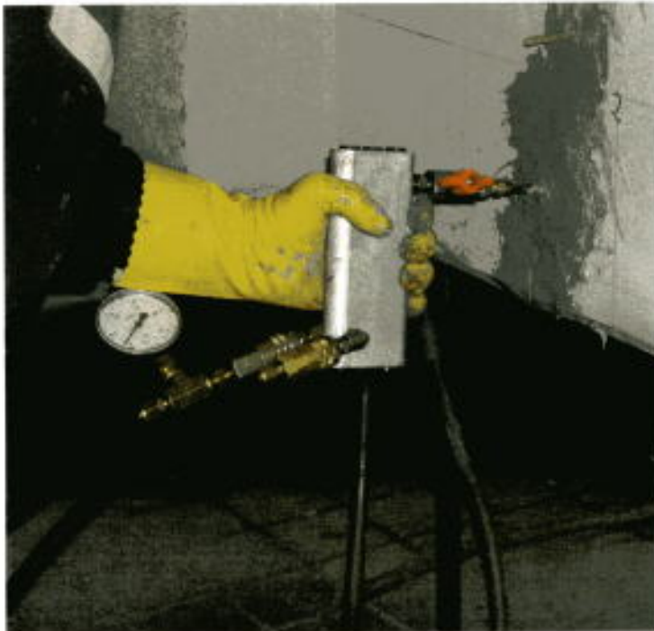
Bild 16: Injektion des unteren Packers
