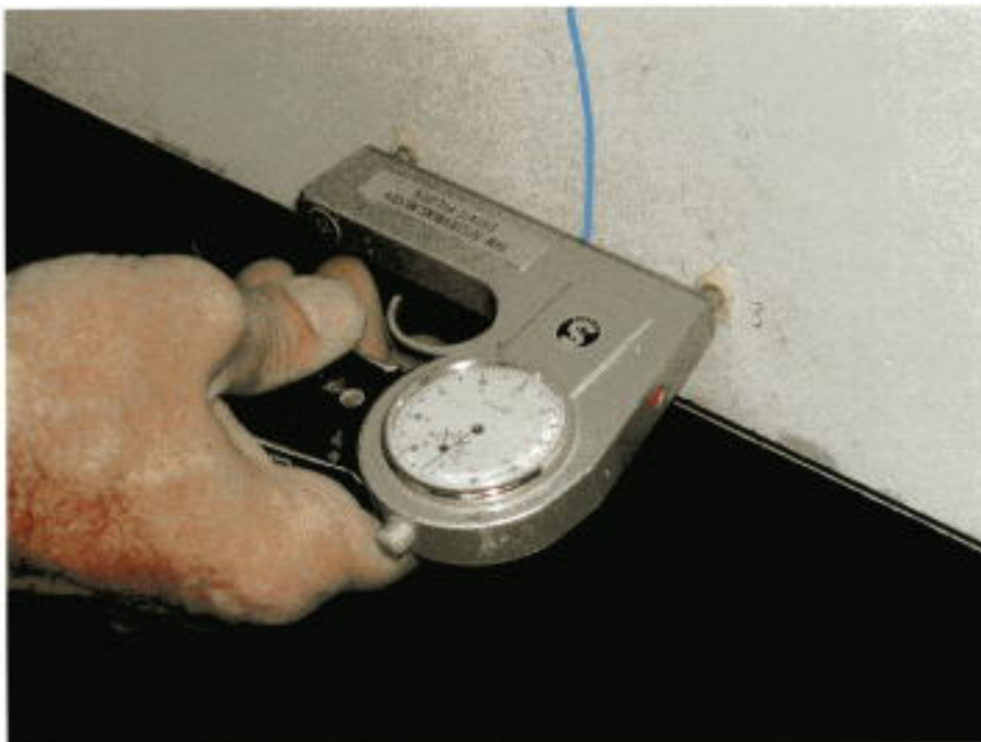
Bild 7: Messung der Rissbreiten
