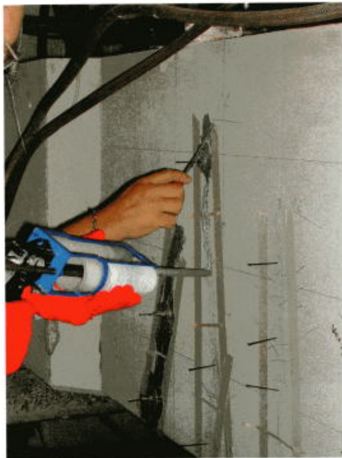
Bild 9: Verdämmen der Risse
