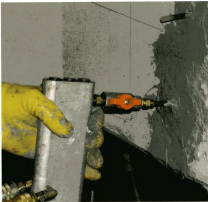
Bild 17: Materialaustritt am nächsten Packer
