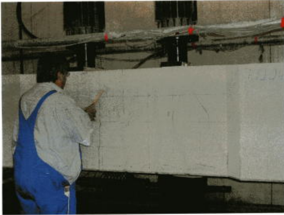
Bild 8: Vorbereitung der Betonunterlage
